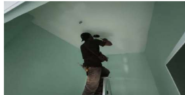
PEKERJAAN MEKANIKAL, ELEKTRIKAL, & PLUMBING
