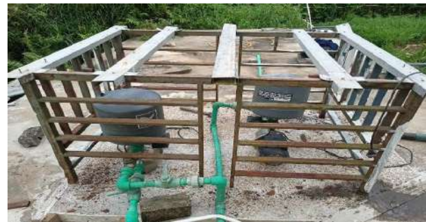
PEKERJAAN RUMAH POMPA
