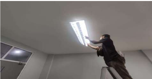
PEKERJAAN MEKANIKAL, ELEKTRIKAL, & PLUMBING
