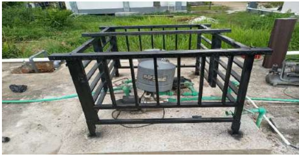
PEKERJAAN RUMAH POMPA
