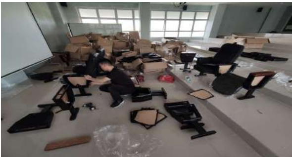
PEMASANGAN KURSI RUANG STUDIO
