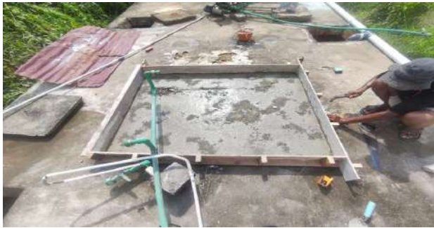
PEKERJAAN RUMAH POMPA
