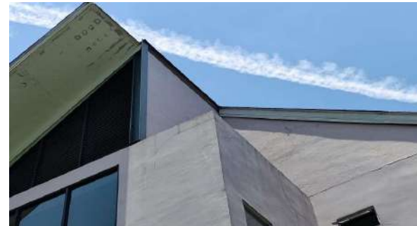
PEKERJAAN INSTALASI AIR HUJAN
