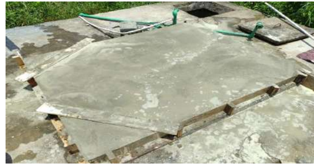
PEKERJAAN RUMAH POMPA
