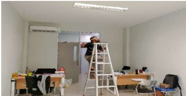
PEKERJAAN MEKANIKAL, ELEKTRIKAL, & PLUMBING
