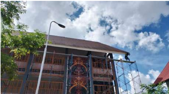
PEKERJAAN INSTALASI AIR HUJAN
