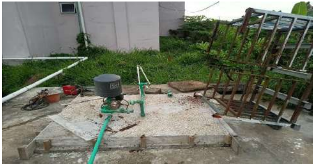
PEKERJAAN RUMAH POMPA
