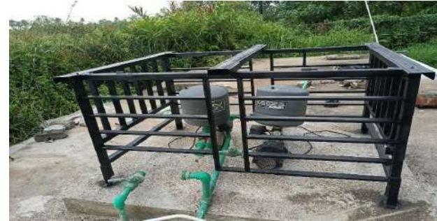
PEKERJAAN RUMAH POMPA
