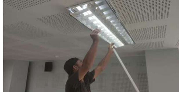
PEKERJAAN MEKANIKAL, ELEKTRIKAL, & PLUMBING
